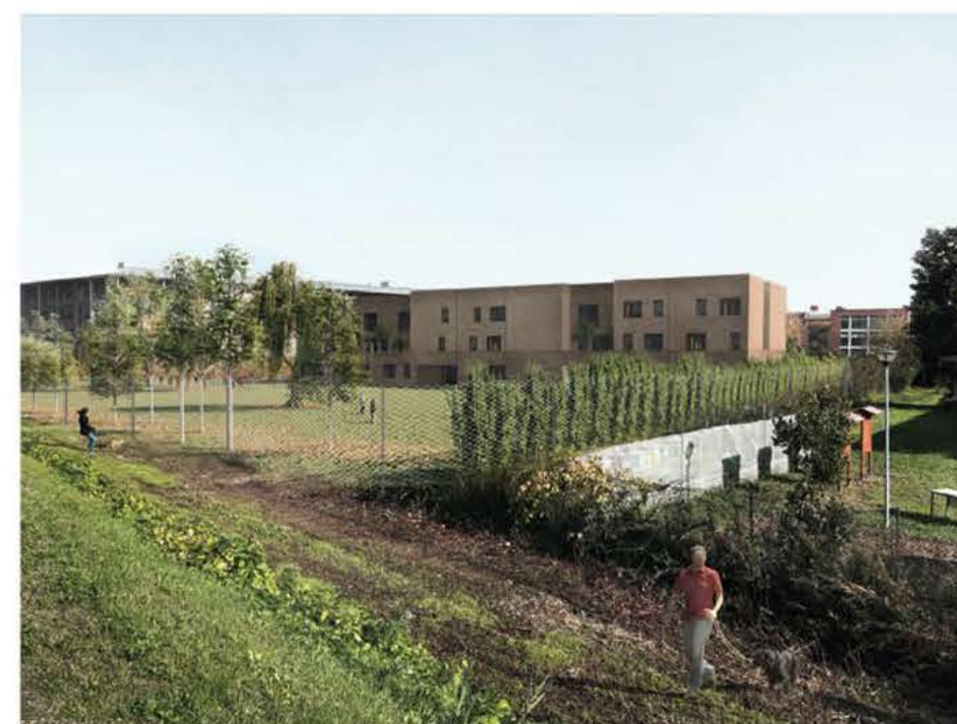
Il prospetto rivolto all'argine del fiume Arno
